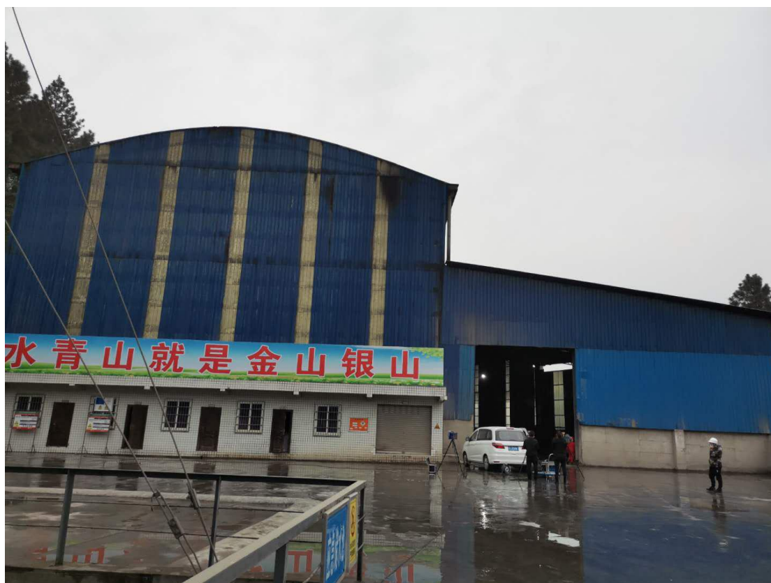
图 3-7 本项目厂房封闭情况 2
