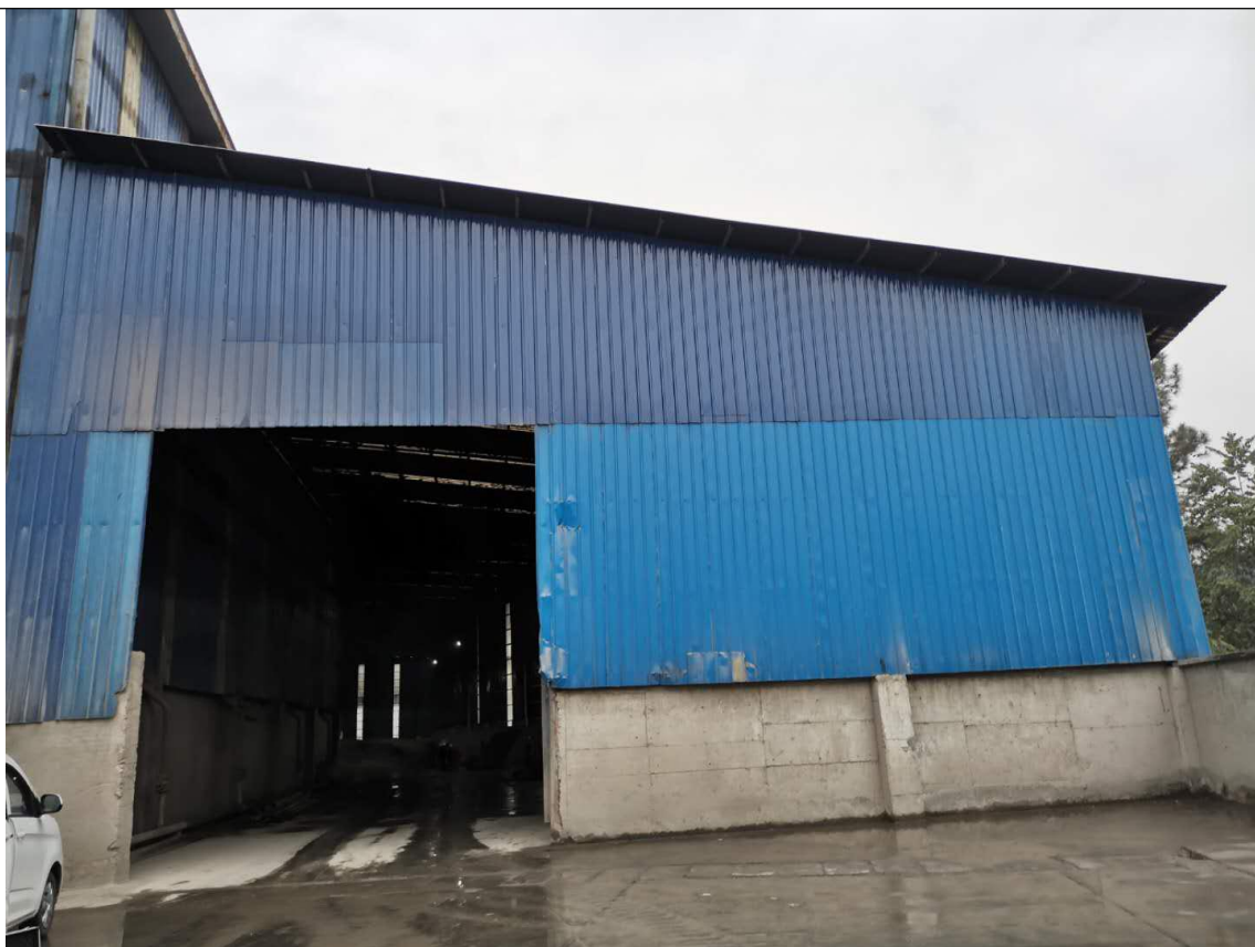
图 3-6 本项目厂房封闭情况 1
