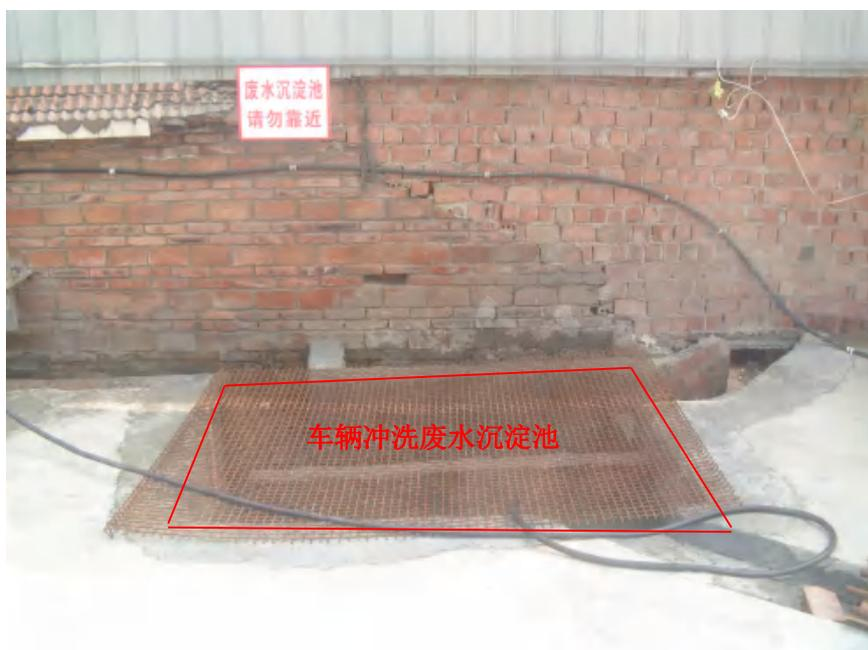
图 3-9 车辆冲洗废水沉淀池照片
