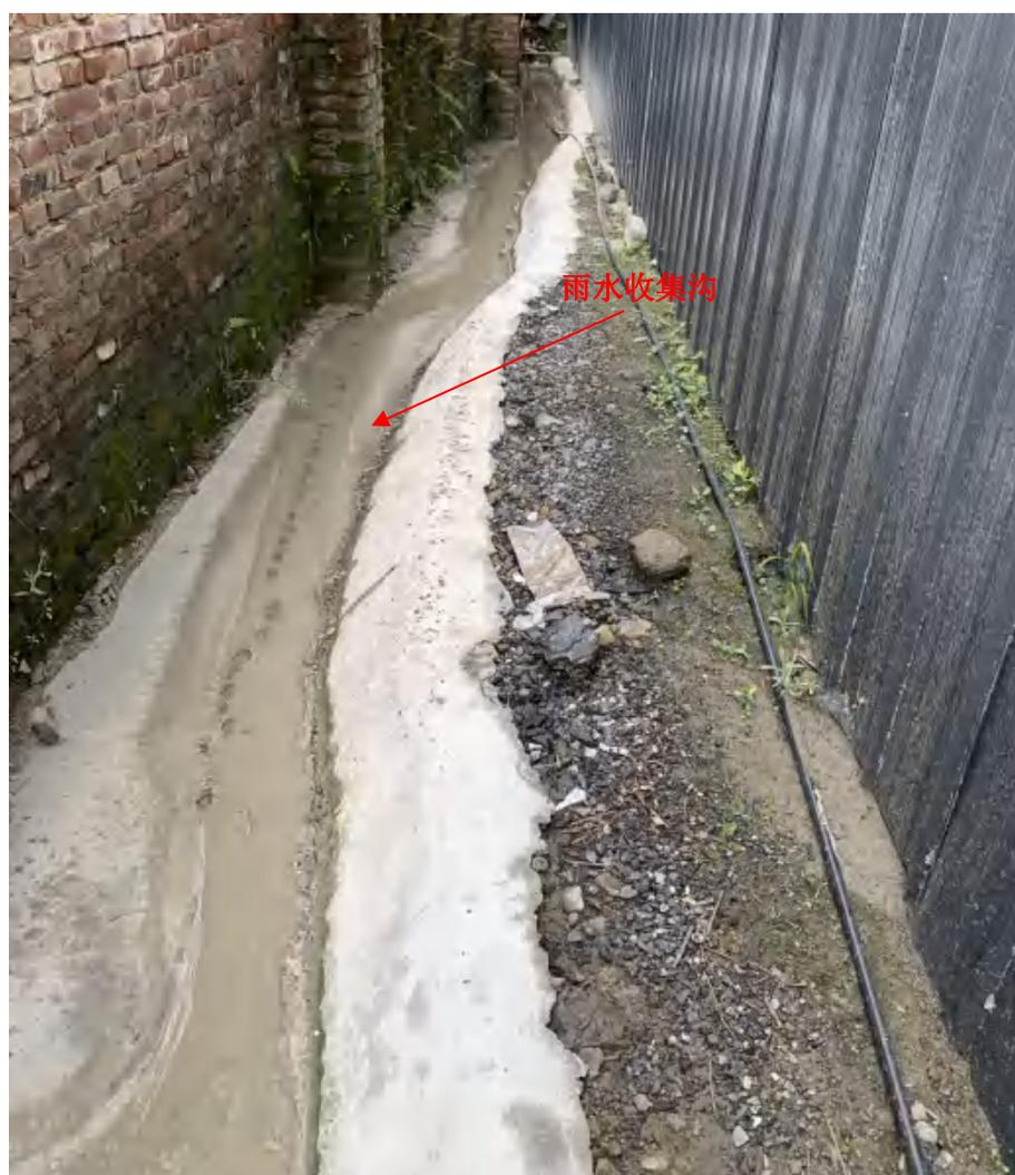
图 3-1 雨水收集沟照片
