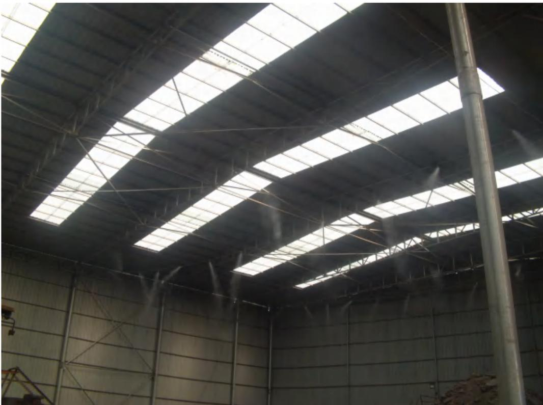
图 3-11 厂房内部设置的雾化喷嘴效果照片
