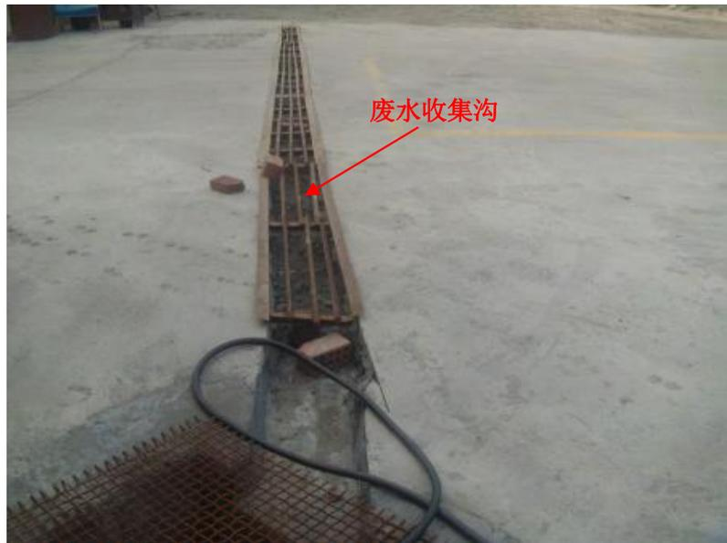
图 3-8 冲洗废水收集沟照片
