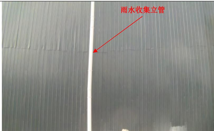
图 3-2 雨水收集立管照片
