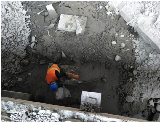
FS13汽轮机组车间基坑积水池清运后
