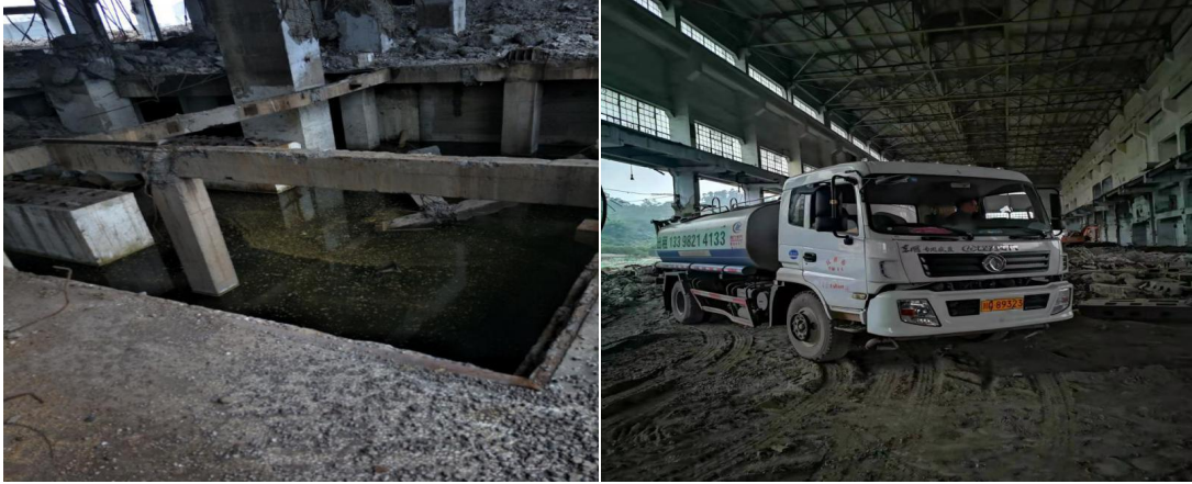
FS13汽轮机组车间基坑积水池清运前、中
