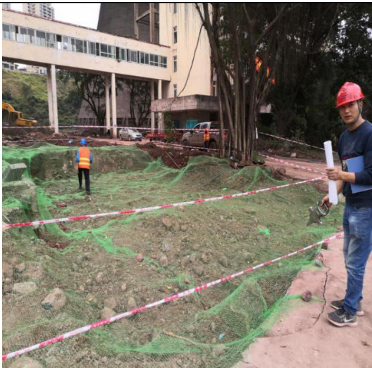
现场修复范围核实
