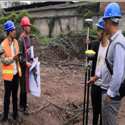
现场修复范围核实
