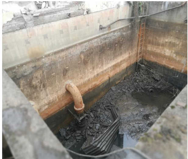
FS12废旧金属破碎车间清洗废水沉淀池清运前、中、后
