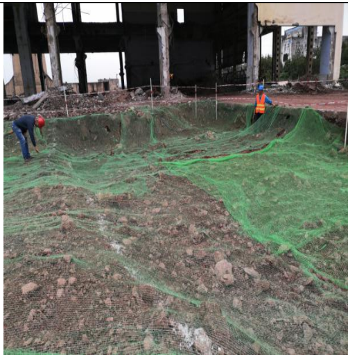
现场修复范围核实
