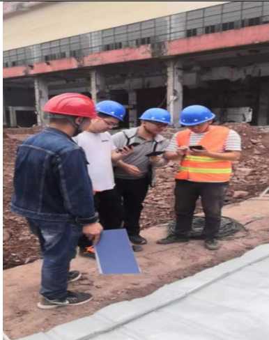
现场修复范围核实
